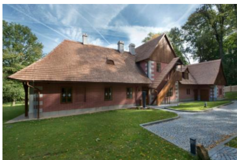
Obrázek 45 Švýcárna po rekonstrukci
