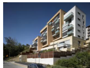
Obrázek 2 Bytový dům Na Topolce
