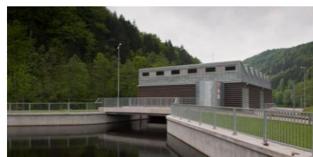
Obrázek 33 MVE Železný Brod na Jizeře
