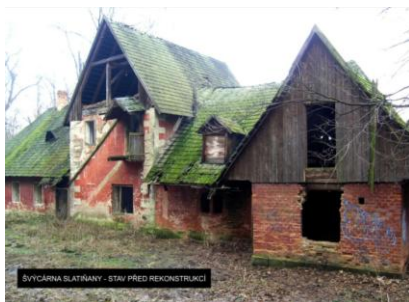
Obrázek 44 Švýcárna před rekonstrukcí
