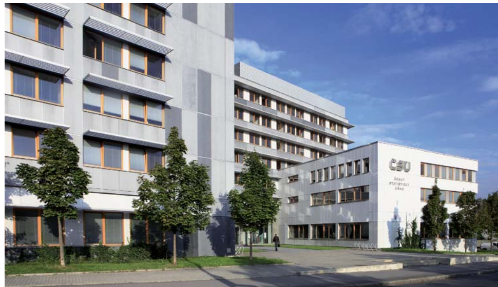
Budova ČSÚ stojí v městské části Strašnice v Praze 10.
